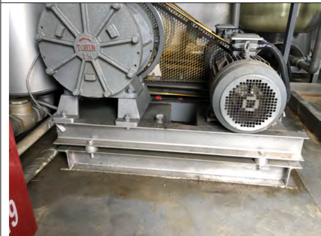
风机基础减振
